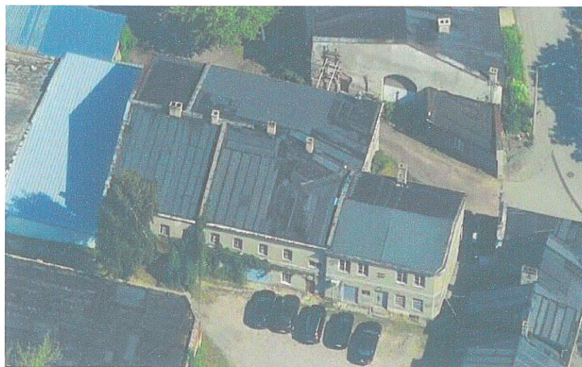
Il. 3. Układ dachów magazynów [budynki 5 i 6]; źródło: http://radom.ukosne.pl/?hg=625
