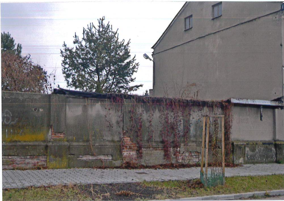
Fot. 2. Mur wzdłuż d. ogrodu, widok od ul. Św. Wacława, fot. P. Szczurek, 2021.
