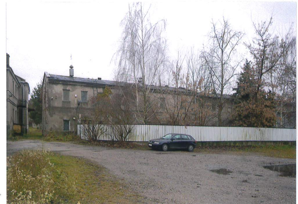
Fot. 5. Budynek pogarbarski [2], widok od podwórza, fot. P. Szczurek, 2021.
